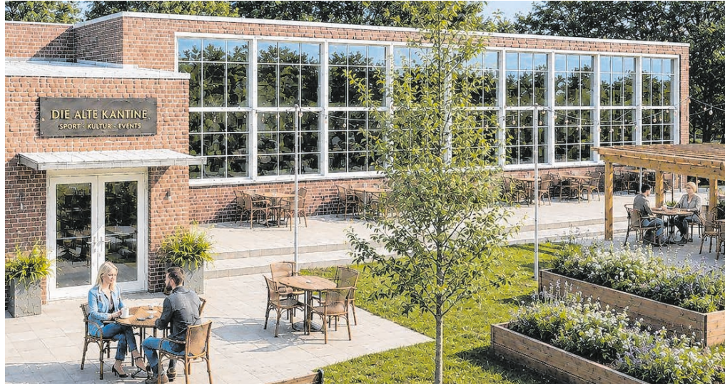
So einladend könnte „Die alte Kantine“ von außen nach der Fertigstellung der Arbeiten einmal aussehen.
